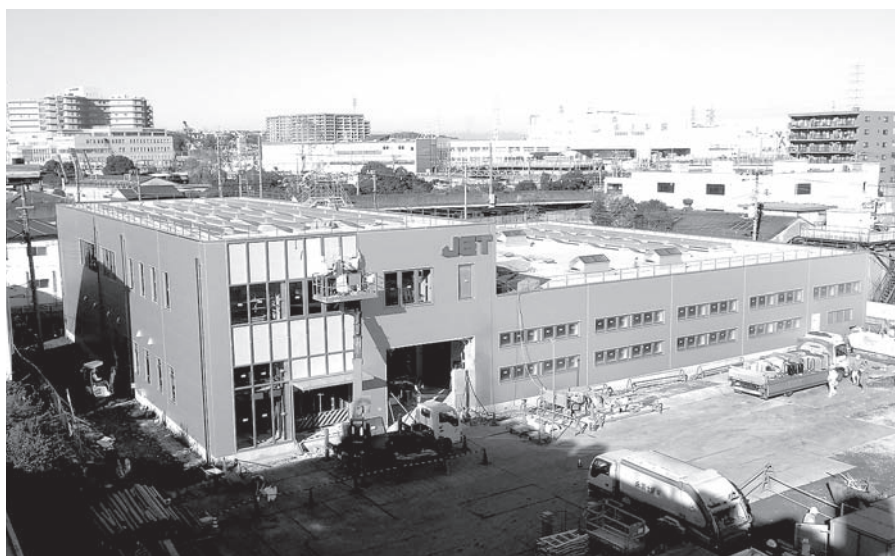
建設中の研究事業センター（平成22年12月中旬撮影）
